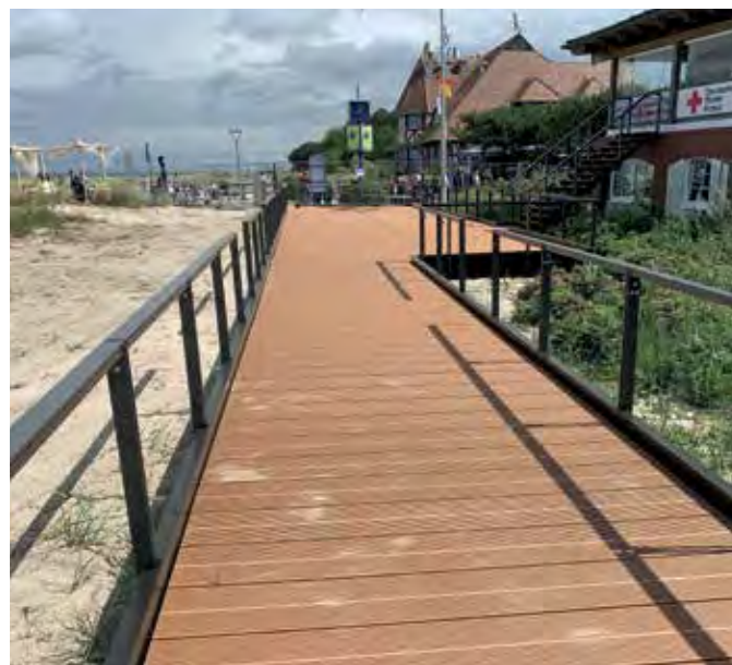
Bei der 2020 neu errichteten Strandpromenade im Ostseebad Zingst mit einer Gesamtfläche von etwa 400 Quadratmetern fiel die Wahl auf einen Belag, der vor allem nachhaltig, pflegeleicht und robust sein sollte.
