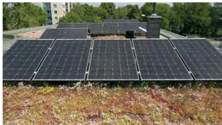
Ein Solargründach in Berlin-Spandau: Die Kombination von Gründach und PV-Anlage erhöht die Lebensdauer von Flachdächern.
