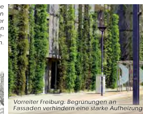
Flexibel einsetzbare Pflanzennetze können an einem oder zwischen mehreren Gebäuden angebracht werden.
