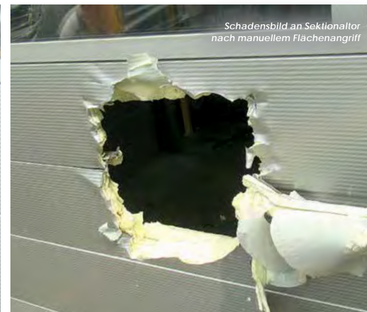
Schadensbild an Sektionaltor nach manuellem Angriff auf die Führungsschiene
