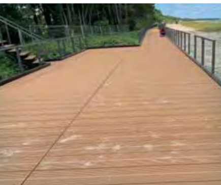
Da die Bohlen kein Wasser aufnehmen und somit nicht verrotten, sind diese ideal für Promenaden an Sandstränden.
