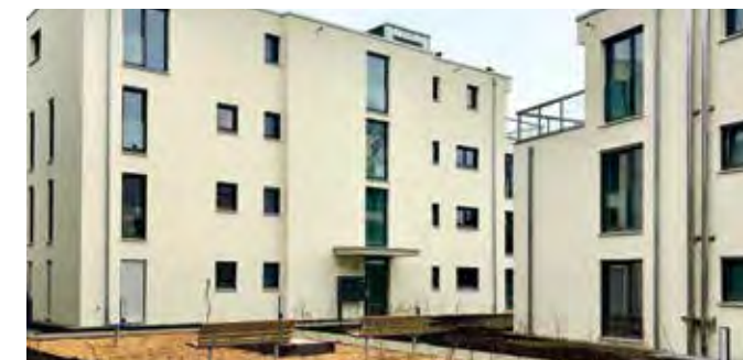
Das Bauprojekt in der Löffel- und Schempffstraße in Stuttgart
