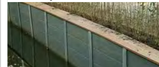
TRIMAX als Uferbefestigung
